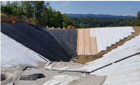
Abbildung 6: Deponiebau - Basisabdichtung
